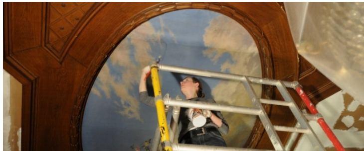
Kronovalls slott. Arbete med taket i blå matsalen.
