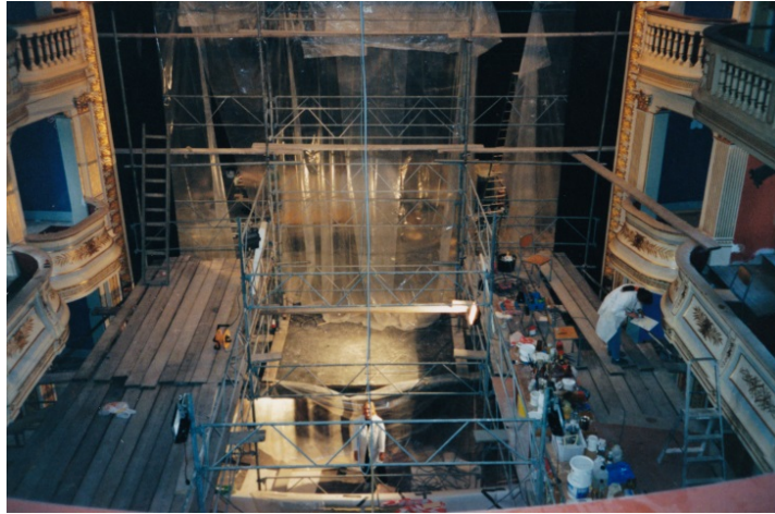
Ystad Teater. Under arbetet med läktar- och logebeklädnaden.
