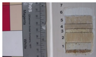
Bäckaskogs slott. Färgtrappa på dörrfoder.
